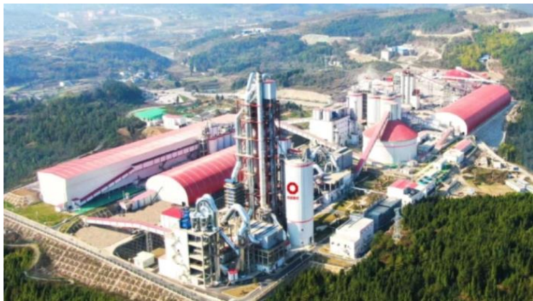
播州西南水泥公司污泥干化项目
